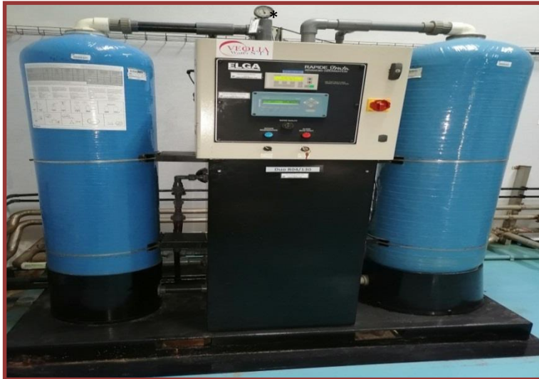
Figure 6 Station de déminéralisation par permutation d'eau brute au sein de l'établissement SAIDAL (photo personnelle).
