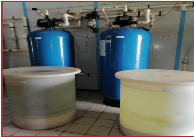
Figure 4 Montage d'une station par des adoucissements en Doublex au sein de l'établissement SAIDAL (photo personnelle).
